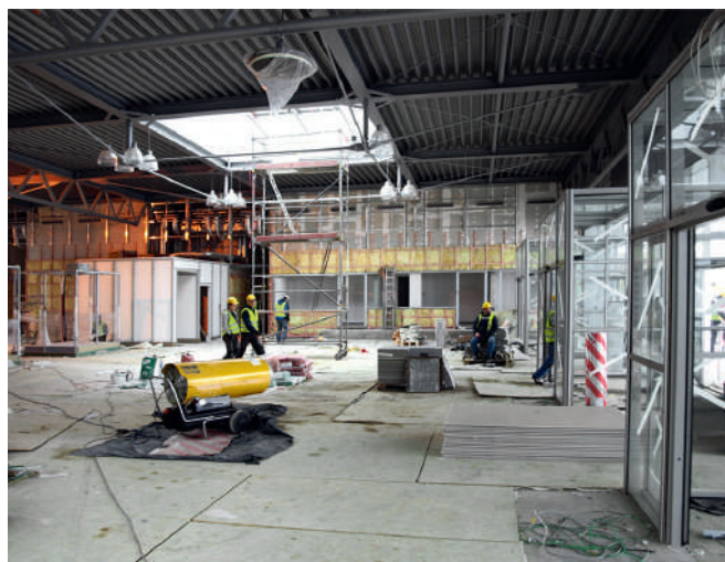
Calefacción en obras (Master B 180)
