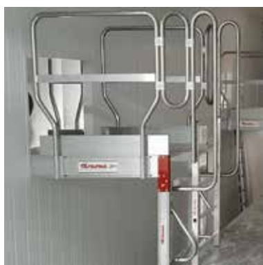
EM1113 Pasarela / Passadiço
