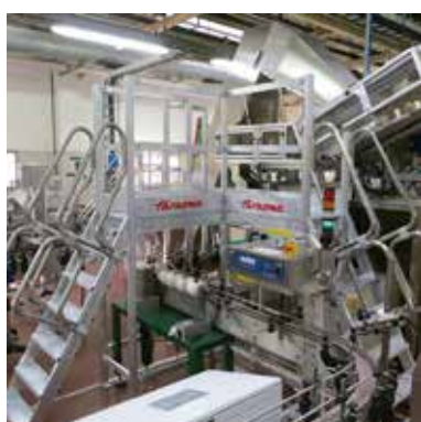
EM1107 Pasarela / Passadiço
